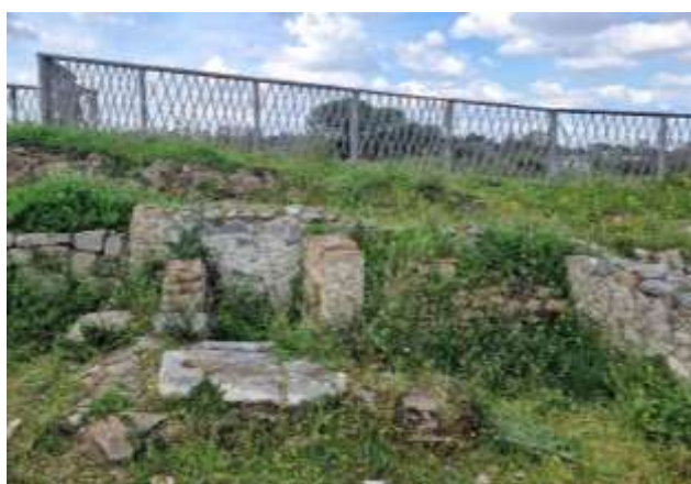
Fig. 1: Il manufatto prima dell'intervento conservativo.
