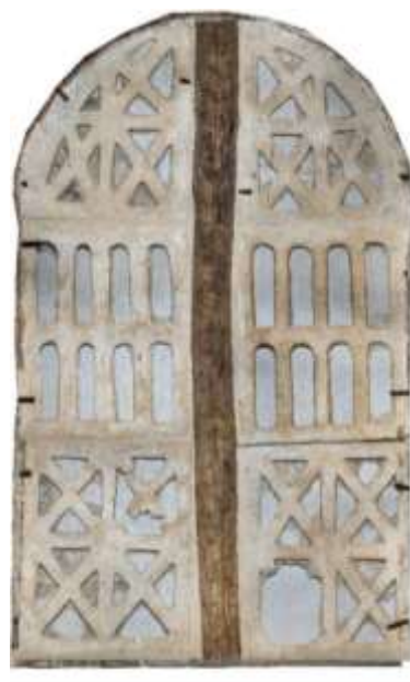
Fig. 4: Transenna di finestra dopo l'intervento conservativo.
