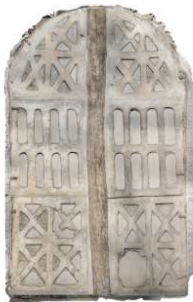
Fig. 3: Transenna di finestra prima dell'intervento.
